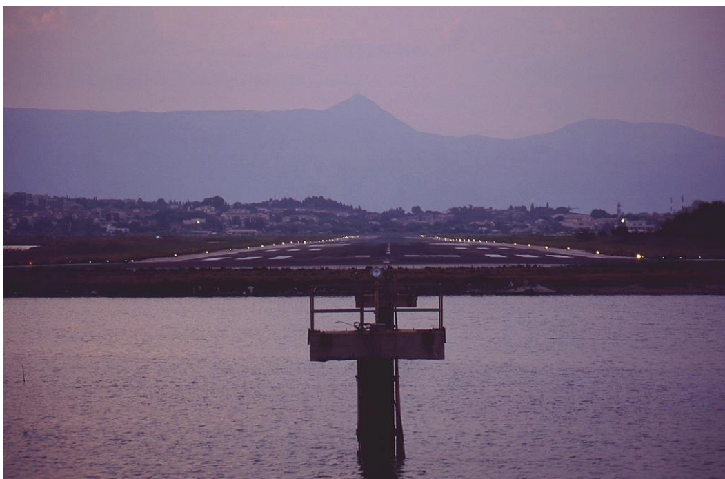
Εικόνα 1 - Διάδρομος αεροδρομίου με αναμμένα τα πλευρικά υπερυψωμένα φωτιστικά.
