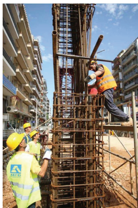
Εικόνες 6, 7 και 8 - Διαδικασία τοποθέτησης κλωβού οπλισμού
