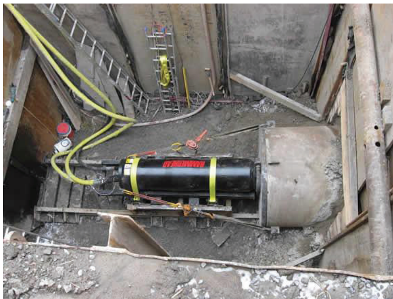
Εικόνα 1 : Τυπική διάταξη κρουστικής έμπηξης ανοικτού σωλήνα
