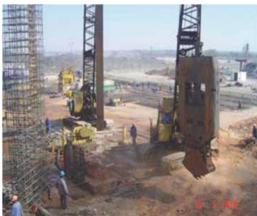
Εικόνα 3 - Αρπάγες μηχανικής λειτουργίας με συρματόσχοινο (μπένες)
