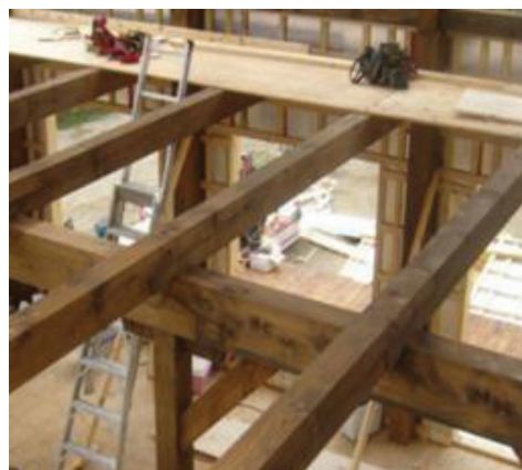
Εικόνα 1 - Ξύλινο καρφωτό δάπεδο απευθείας σε φέρουσες δοκούς (ποταμούς)
