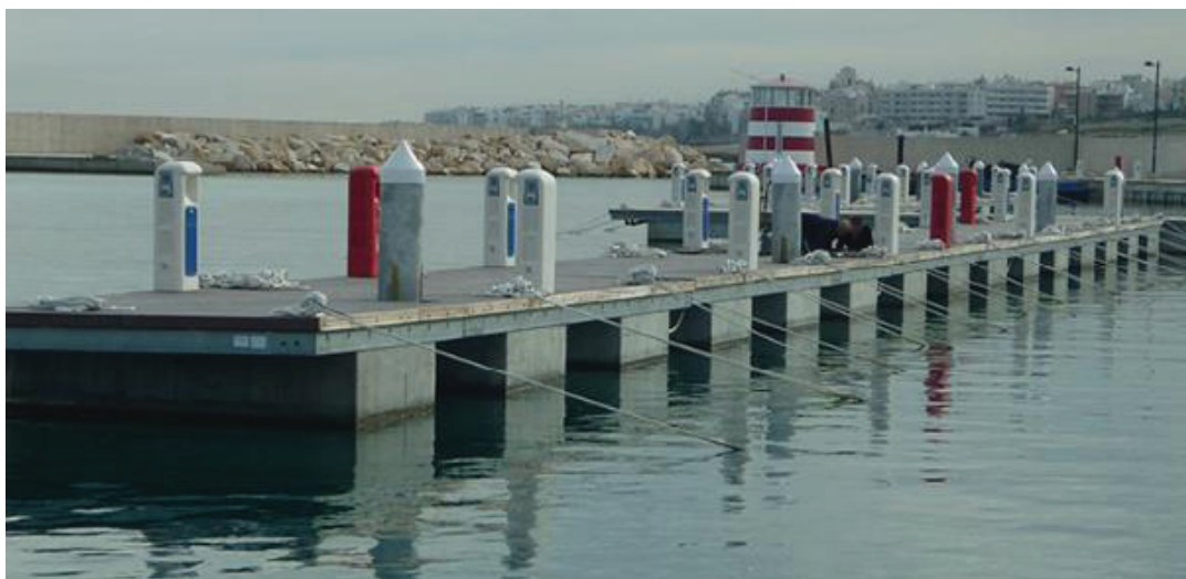
Εικόνα 3: Τυπικό σύστημα αγκύρωσης πλωτού προβλήτα
