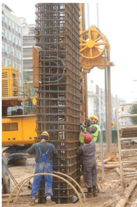
Εικόνες 6, 7 και 8 - Διαδικασία τοποθέτησης κλωβού οπλισμού
