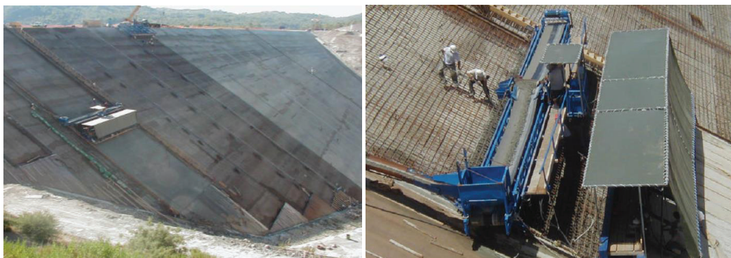
Εικόνες 1 και 2 - Τυπικό φορείο σκυροδέτησης ανάντη πλάκας σκυροδέματος
